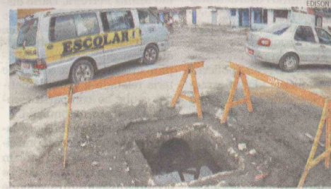
Fechamento do buraco está prometido para o final desta semana
